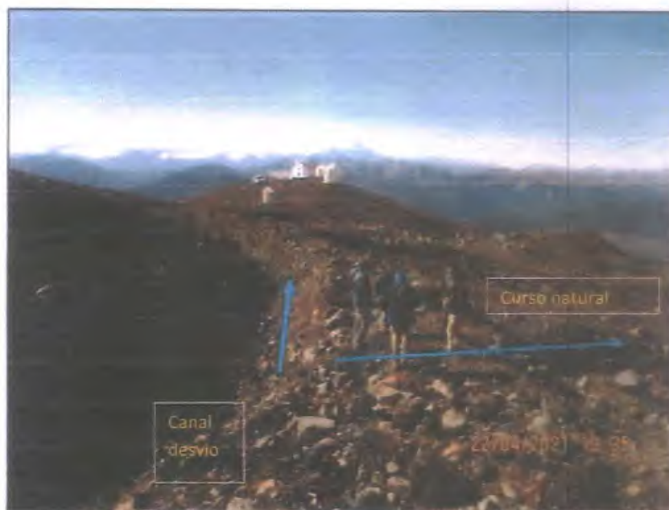
Figura 1.- Punto de control 1. Se aprecia personal ubicado en plena obstrucción artificial de las aguas, cuyo cauce natural fluía hacia la cuenca del Lago Maihue (hacia la derecha en la foto), encauzándolas mediante canales, hacia la cuenca del Lago Panguipulli, predio Pilmaiquén (hacia la izquierda en la foto).
